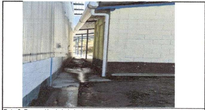
Foto 5: Reparación de bajada de agua plubial, tubo PVC 4", módulo 1.
